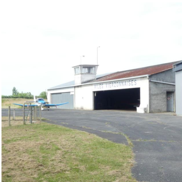
Photo 12 : Bâtiments et hangars – MM, 09/2025
